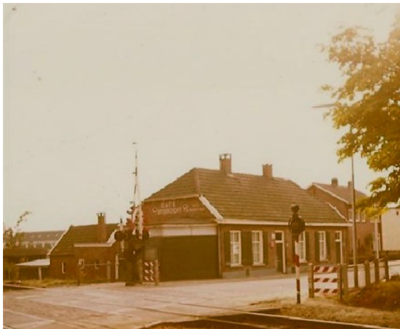
Cafe Mentink aan de Deldensestraat. Volgens overlevering hebben destijds werknemers van machinefabriek Ledeboer (gevestigd aan de overkant van de straat) een tunnel gegraven onder de straat door naar het cafe met medeweten van de kastelein. Dit als reactie op het besluit van Ledeboer om een grote muur langs de straat te laten metselen om zo clandestien drinken te voorkomen. Het ging de werknemers niet alleen om de drank maar ook om ontspanning want in die jaren (tweede helft van de negentiende eeuw) was er nauwelijks zoiets als een verenigingsleven. Bron: MijnStadMijnDorp/HIP Borne
